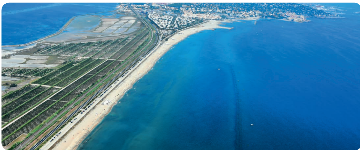
▲ Atténuateur de houle en géotubes pour la protection de plages à Sète. © BRL/IGL
