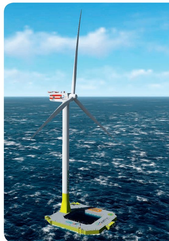
▲ Représentation (image de synthèse) d'une éolienne flottante sur une plateforme semi-submersible. © Quadran Énergies Marines
